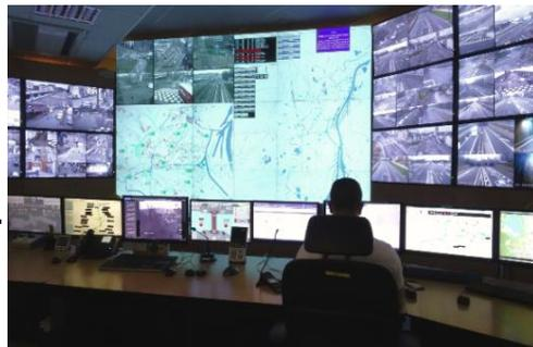
Le Service de l'Information et de la Régulation Automatique de la Circulation a été créé afin de faire face au trafic grandissant de l'agglomération strasbourgeoise. QG de la circulation, il permet de réguler les flots de véhicules sur l'agglomération et d'agir en temps réel sur les points noirs afin de fluidifier le trafic. Pour ce faire, le service s'est équipé de différentes installations techniques pour faciliter le travail des opérateurs qui veillent 24h/24 à la sécurité des usagers.
