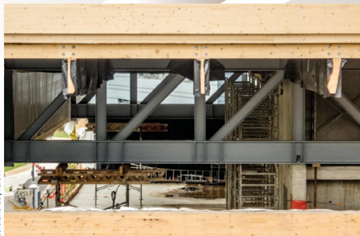
➔ Visite de chantier de l'extension-restructuration de l'INSA Strasbourg
